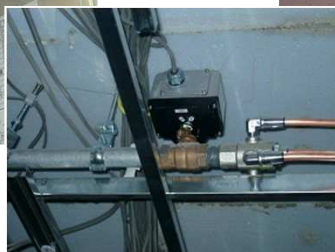
放出口4個タイプ分岐管の施工
