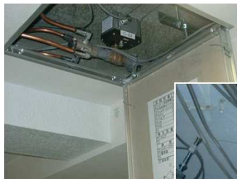
選択弁等への 点検口施工
